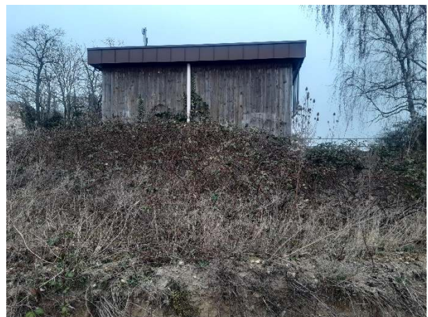
Foto 4: Bestehendes Hüttchen im Plangebiet (Ankunftshäuschen von "hinten")
