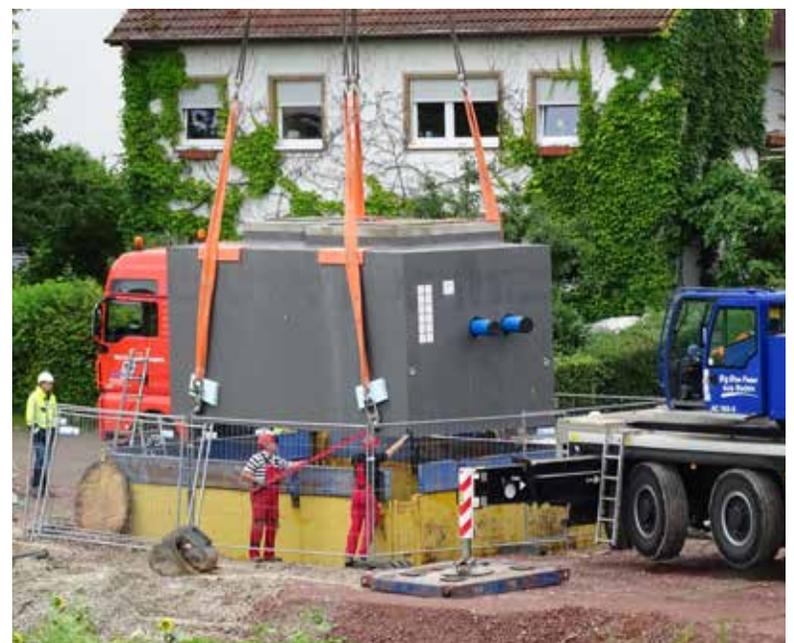
Foto: Ein Schwerlastkran hat am Donnerstag die Brunnenstube auf den 18. Schutzbrunnen in Hochstetten gesetzt. Foto: RPF
