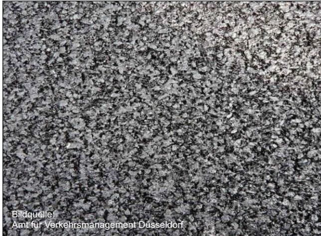
**Beispiel Oberfläche lärmoptimierter Asphalt**
