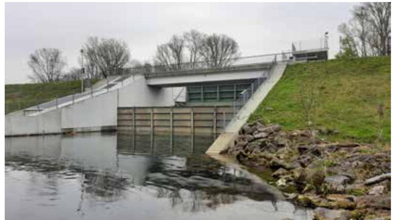
Foto: Notverschluss unterhalb des Möhlinwehrs/ Foto: RPF
