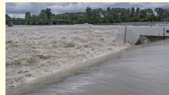
Hochwasser am Kulturwehr Breisach im August 2007
