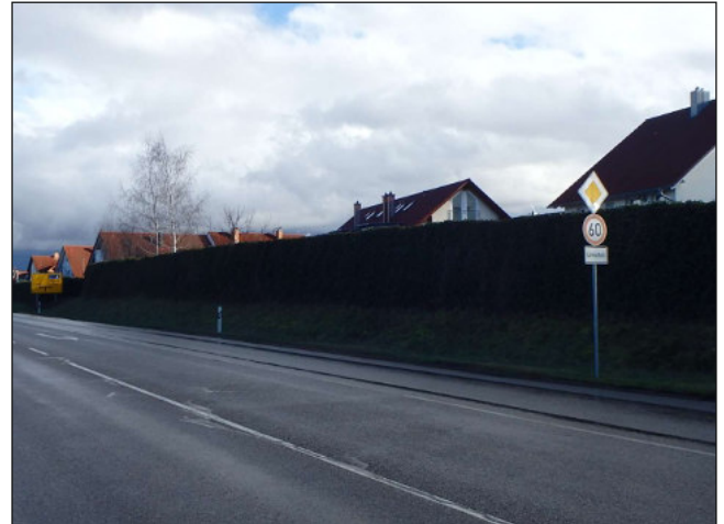
Lärmschutzwand an der Hafestraße
