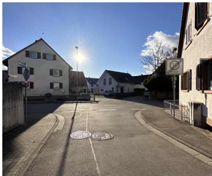
Abbildung 28: Einschränkung der Sichtfelder im Einmündungsbereich des Schneckenwegs
