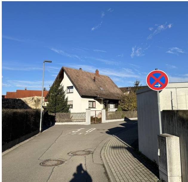
Abbildung 7: Eingeschränkte Sichtfelder im westlichen Abschnitt, Quelle: FWT
