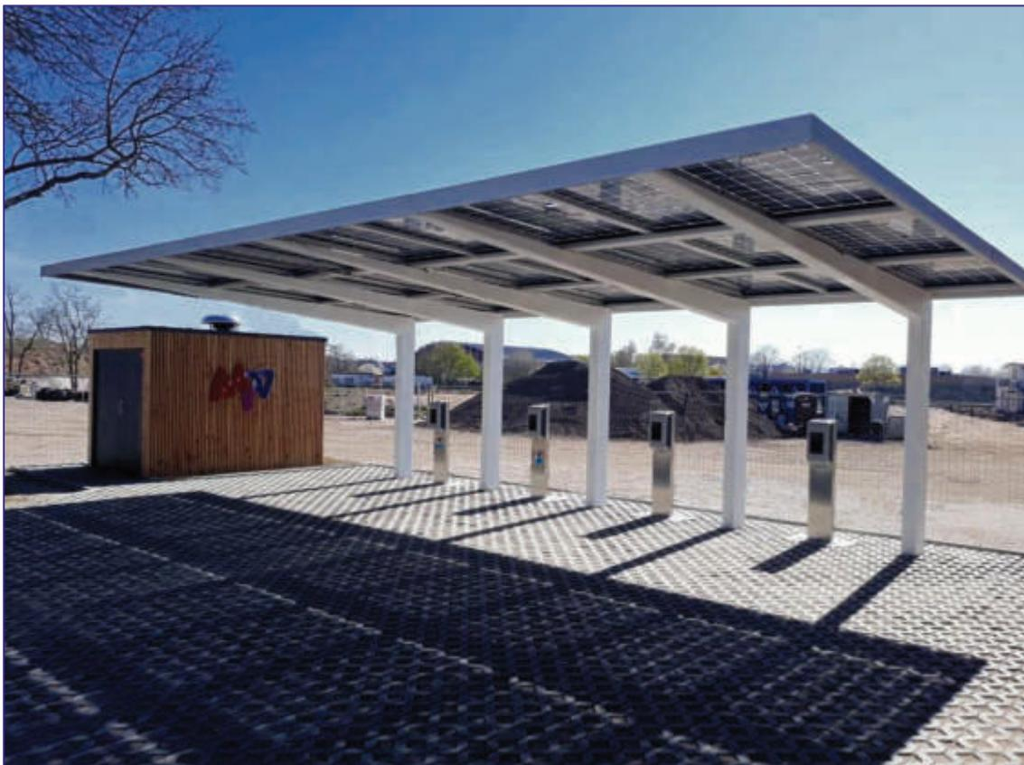
Abbildung 47: PV-Carport von Clickcon mit 10 kWp Solarleistung (Quelle: eigenes Bild).
