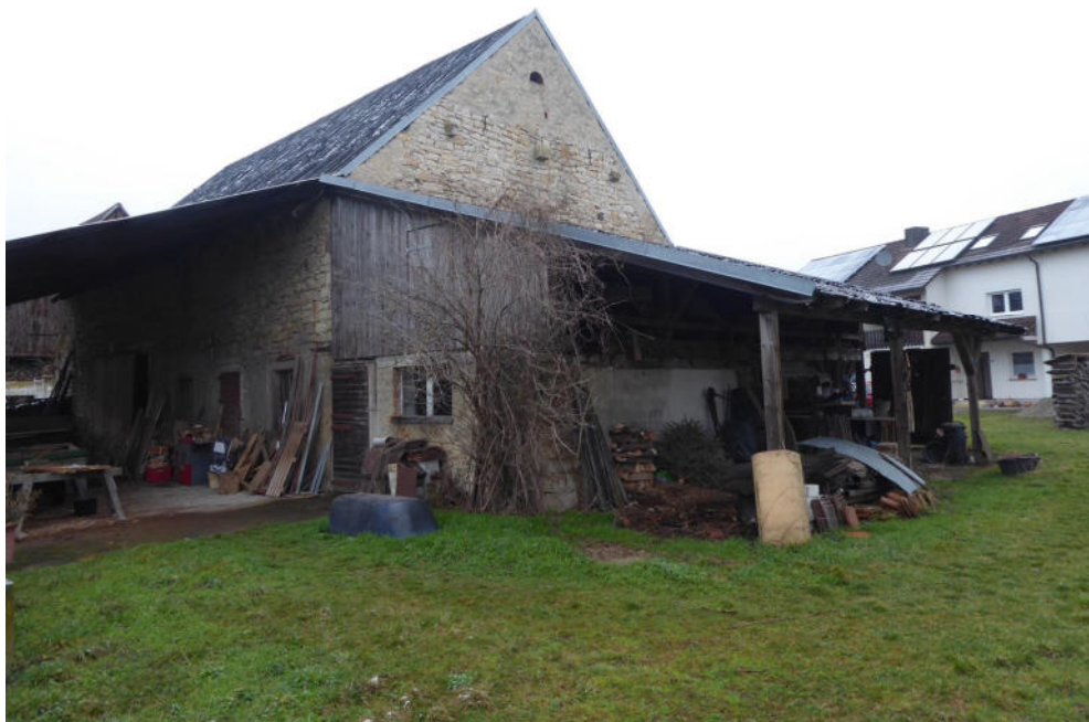
Foto 4: Scheune mit Wohngebäude im Hintergrund (Foto vom 09.01.2021, Blickrichtung Nordwest).
