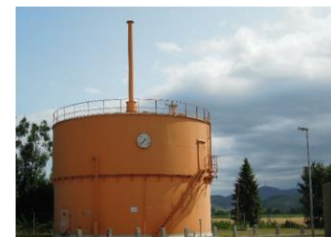
Niederdruckgasbehälter
