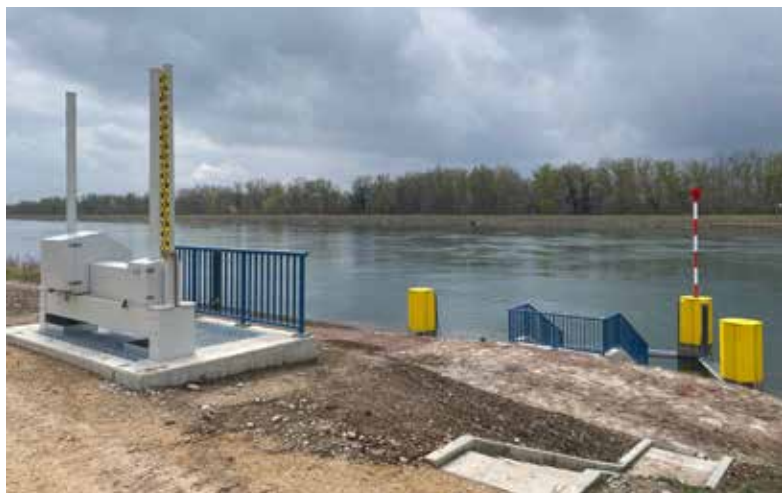
Foto: Das kleine Einlassbauwerk ist größtenteils in den Rheinseitendamm eingebaut worden - deshalb ist an der Oberfläche nicht viel zu sehen. Foto: RPF
